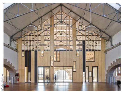
Construits au XIX<sup>e</sup> siècle, les Ateliers des Capucins dans l'Arsenal de Brest ont fait l'objet d'une reconversion par les architectes Julie de Legge et Pierre Lelièvre de l'Atelier L2. Les modules CLT ont été ignifugés avec le Verniflam PV33 - un système intumescent translucide pour le bois qui améliore la performance de réaction au feu.
