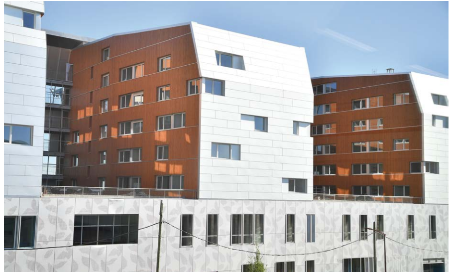
▲ La façade côté Zac reçoit un bardage de 20 mm en aluminium anodisé, lequel est perforé de trois motifs de feuilles de chêne jusqu'au R + 2. Du R + 2 au R + 7, il s'agit toujours de tôles en aluminium anodisé de la même couleur que celles du côté A6.
