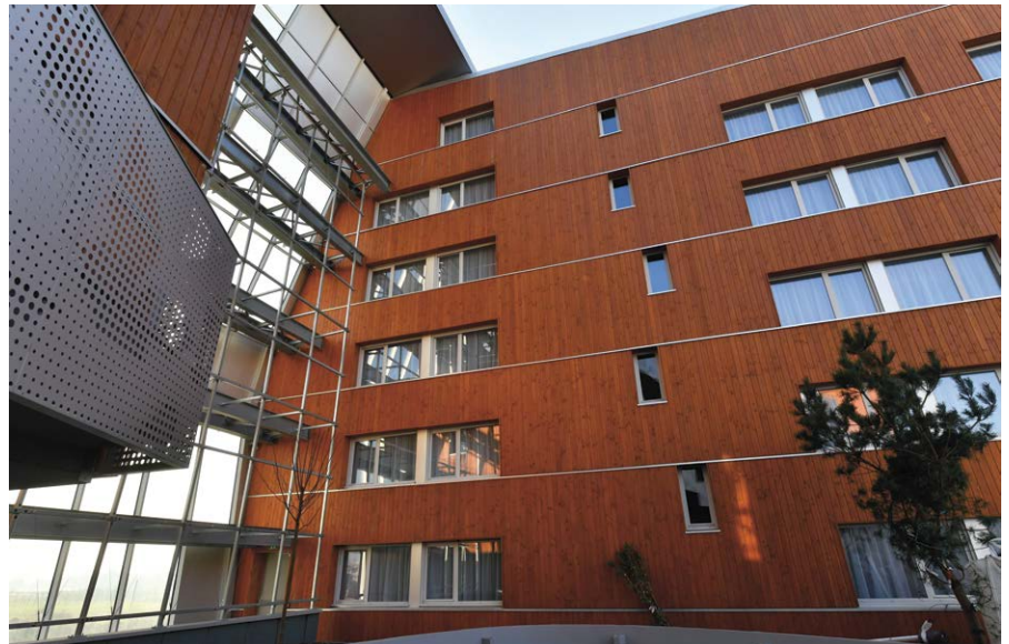
▲ Les façades intérieures des bâtiments sont revêtues d'un bardage en Douglas de 21 mm.
