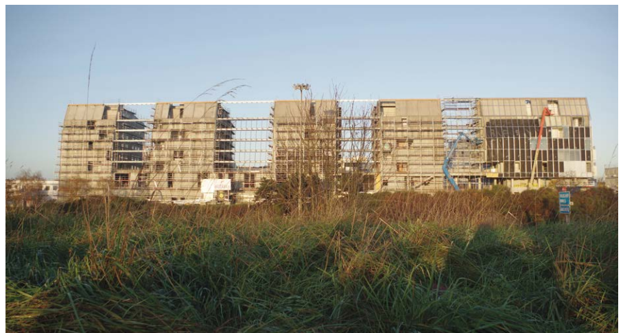
▲ Les caissons acoustiques en aluminium diffèrent, selon qu'ils recouvrent les parties en dur, qui correspondent aux cinq bâtiments, ou l'entre-deux bâtiments – dans ce cas-là, ils sont plus conséquents pour compenser l'absence de béton.
